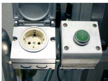
Stromversorgung im Arbeitskorb
